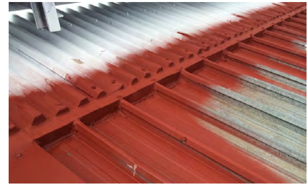
* Etch primer applied over silicone
