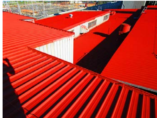
Post rust converter & primer coats:
